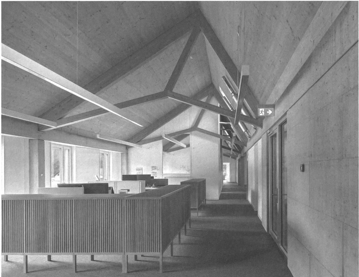
Das Holztragwerk liegt genauso offen wie die Gebäudetechnik: Büros und Empfang im 2. Obergeschoss.
