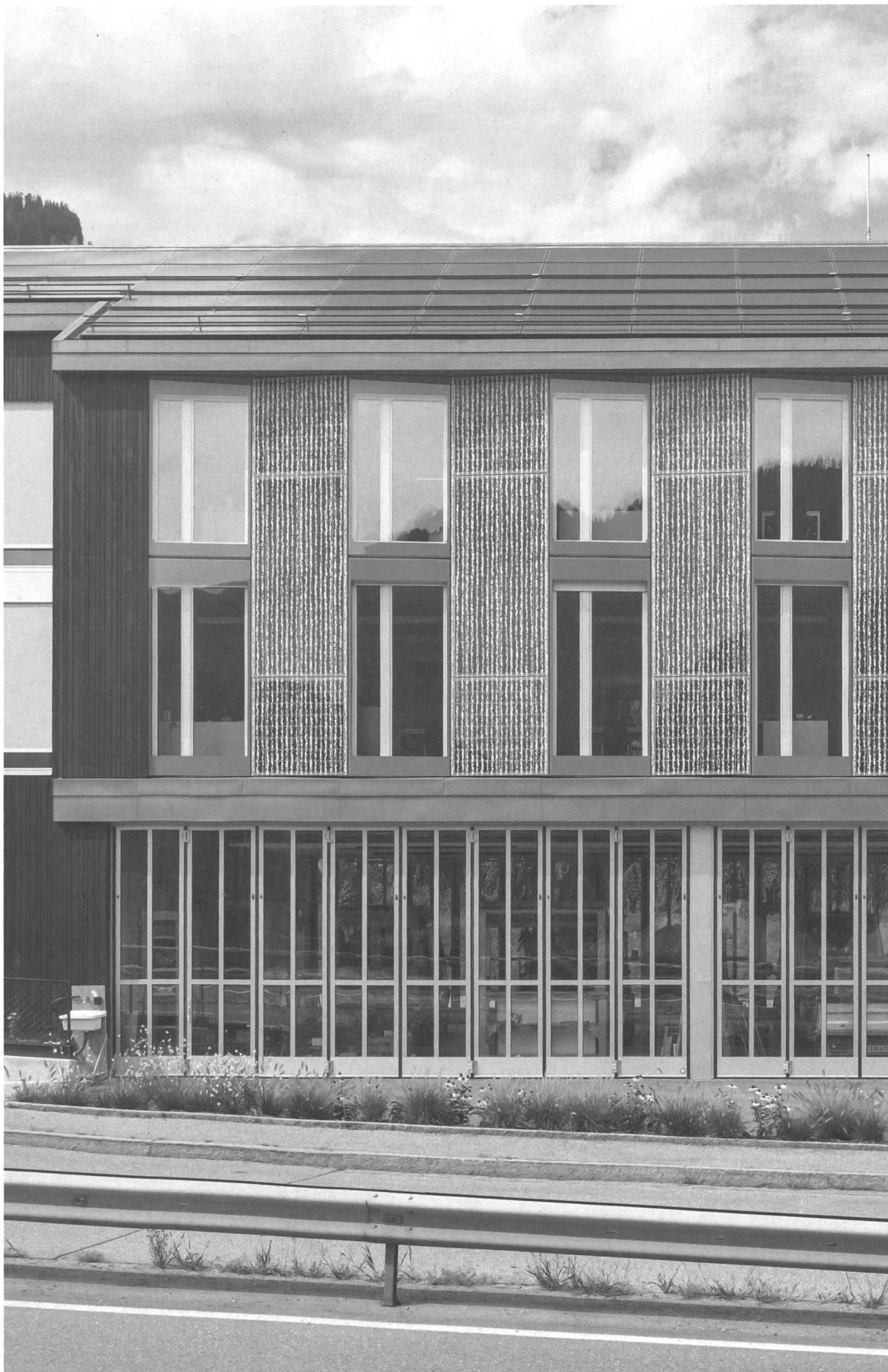
Zweimal Photovoltaik: dezent auf dem Dach, als Schmuck zwischen den Fenstern.
