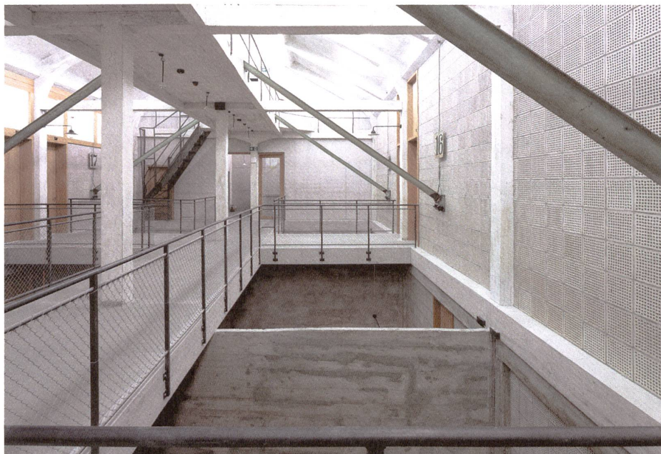
Die alte Struktur – Silowände, Betontragwerk und Trasse des Förderbands – bleibt sichtbar.
