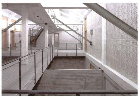
Die alte Struktur – Silowände, Betontragwerk und Trassee des Förderbands – bleibt sichtbar.
