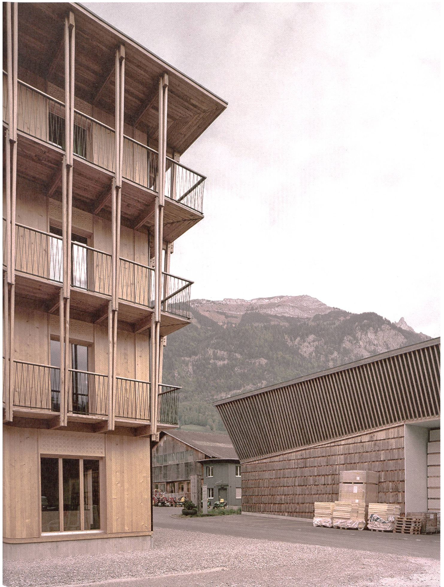
Eichenlauben vor Vollholzwänden: Das Bürohaus der Holzbaufirma Küng in Alpnach braucht weder Dämmung noch Sonnenschutz.
