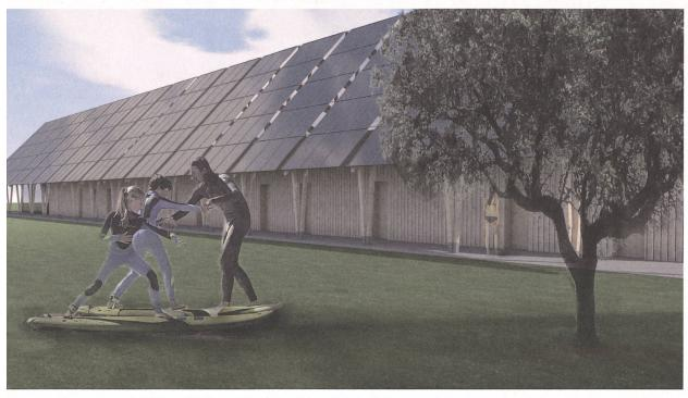
$Sonnenstrom\ als\ Zeichen:\ Die\ filigrane\ Dachkonstruktion\ tr\"{a}gt\ eine\ Solaranlage\ als\ Dachhaut.$
