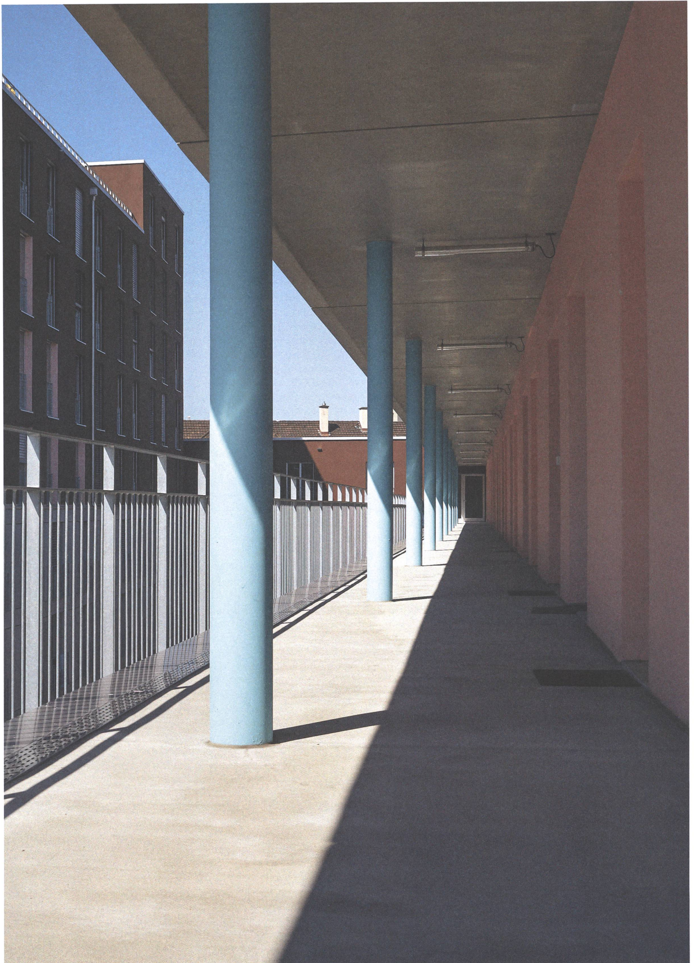
Pastellfarben tänzeln über Stützen, Türen und Betonwände und beatmen die superserielle Struktur.
