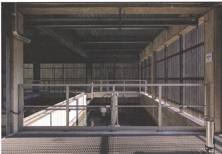
Die Holzlamellen erlauben eine Luftzirkulation, was eine technische Lüftung erübrigt.
