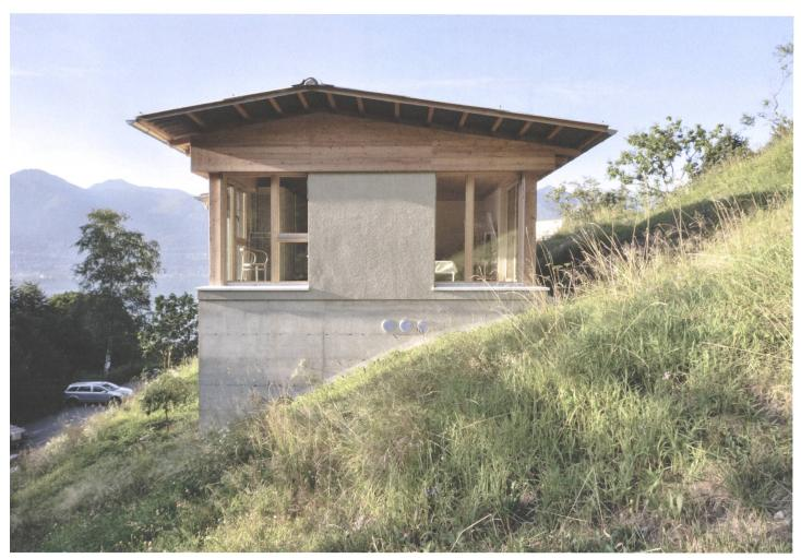
$Zwischen \ Betonsockel\ und\ Holzdach\ wechseln\ sich\ Einsteinmauerwerk\ und\ Fensterflächen\ ab,\ die\ sich\ zum\ Lago\ Maggiore\ wie\ zum\ Wiesenhang\ \"offnen.$
