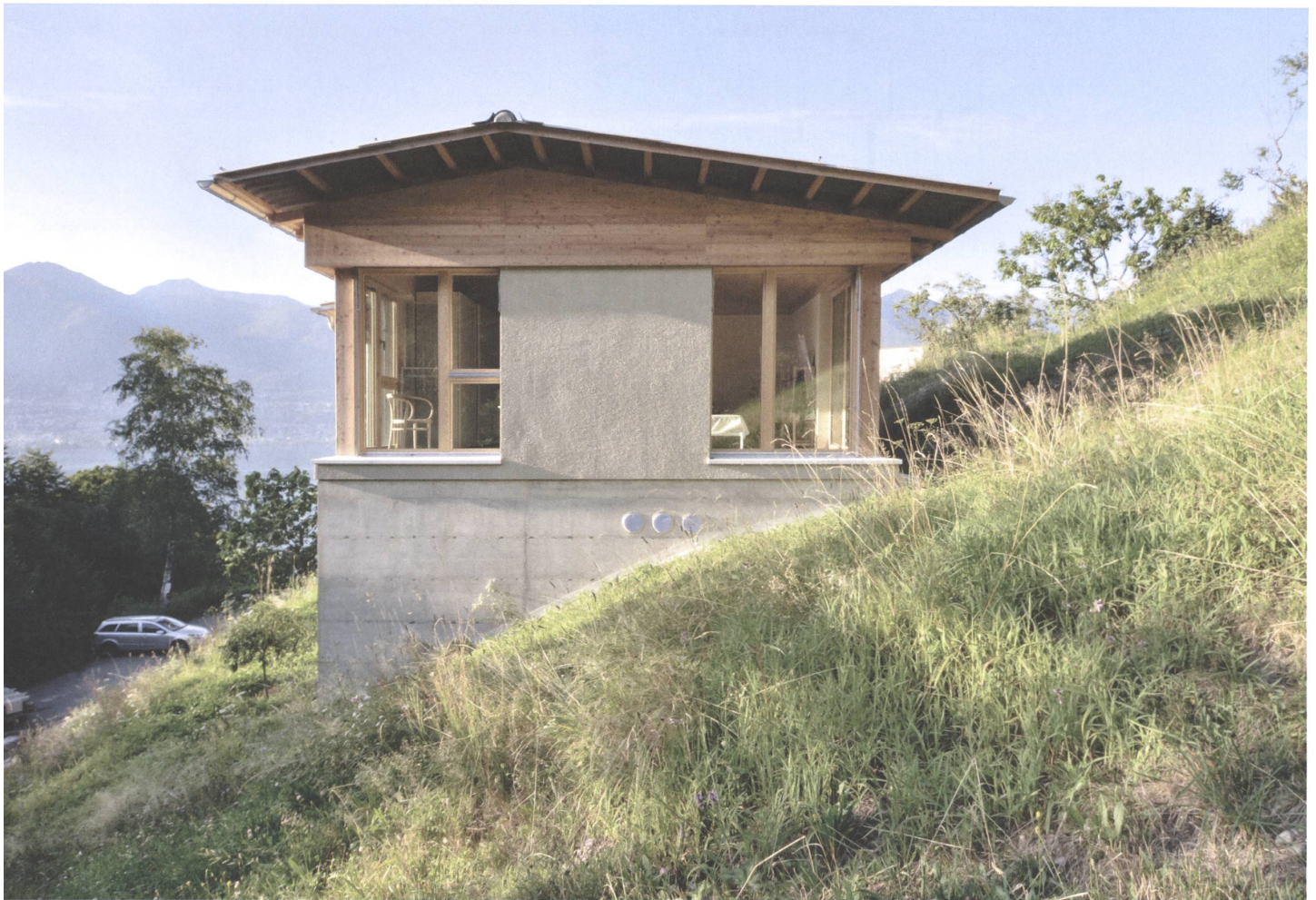
Zwischen Betonsockel und Holzdach wechseln sich Einsteinmauerwerk und Fensterflächen ab, die sich zum Lago Maggiore wie zum Wiesenhang öffnen.
