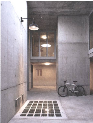
Doppelgeschossige Hallen im Turmbau.
