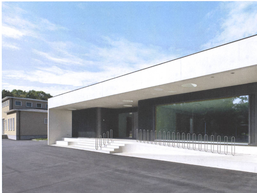
Schon der Eingang des Pumpwerks Lange Erlen in Basel macht klar: Es ist weit mehr als ein technisches Werk.
