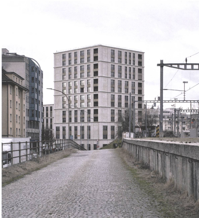
Betonorgie in einem Entwicklungsgebiet an den Bahngleisen in Freiburg: Les Arsenaux.
