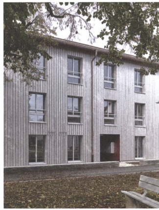
Fassadenelemente aus vorvergrautem Holz prägen die Siedlung Talgut.
