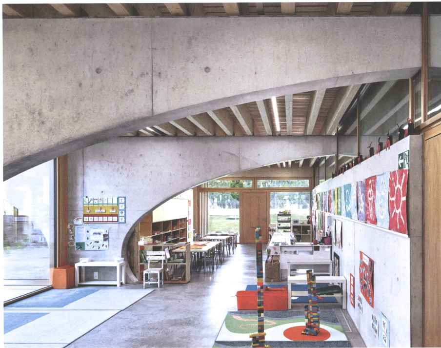
Die hölzernen Dachträger des Kindergartens in Morbio Inferiore ruhen auf zwei Reihen geschwungener Betonträger.
