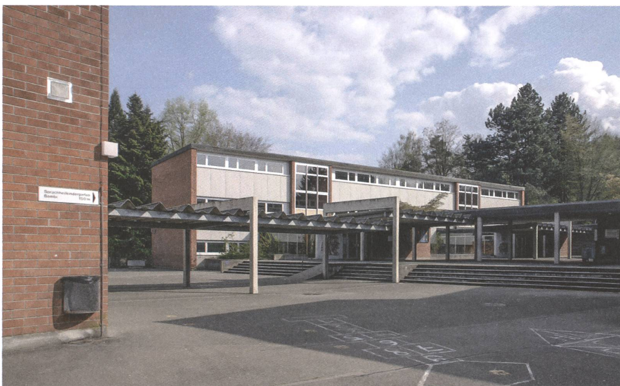
Pausenhof mit überdeckten Verbindungswegen.
