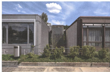
Glasbaustein-Lift zwischen den beiden Bauetappen.
