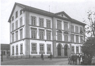
Schulhaus Gutenberg, Winterthur-Töss.
