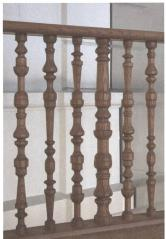
Der Klon und die Skizze: Die Putzfassade wurde in Holz nachgebaut, die Geländerstangen im Foyer nach historischem Muster ruppig CNC-gefräst. Fotos: Herzog & de Meuron
