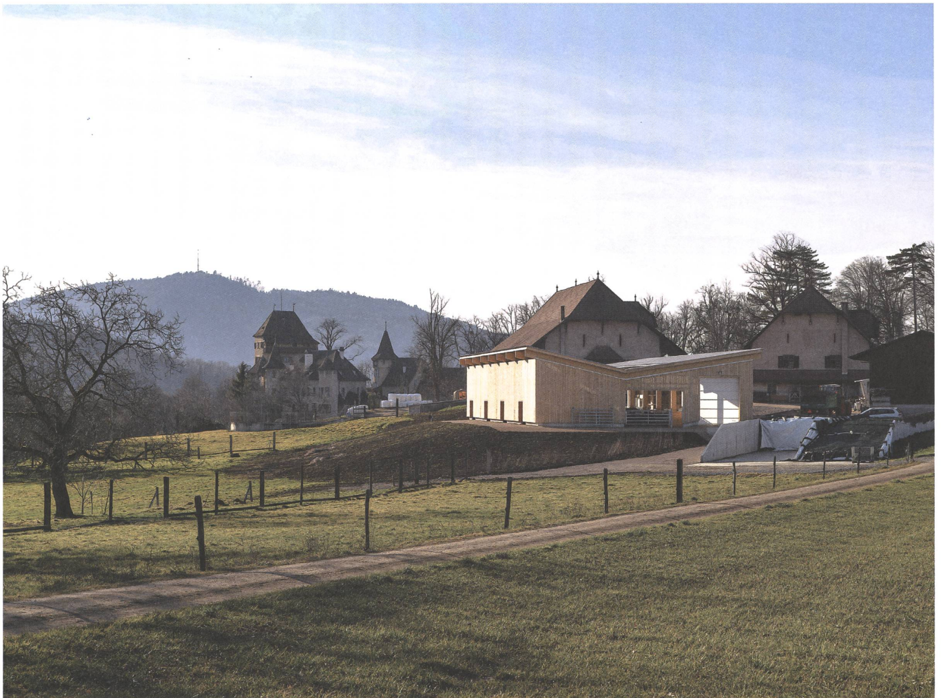
Gutsbetrieb Wildenstein in Bubendorf: Mit einer leichten Holzkonstruktion setzt sich der neue Stall vom alten Betrieb ab und stärkt so das Ensemble. Fotos: Thomas Jantscher
