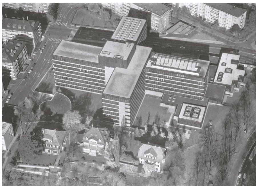
Luftaufnahme der PTT-Generaldirektion kurz nach der Fertigstellung 1970. Foto: ETH-Bibliothek, Bildarchiv
