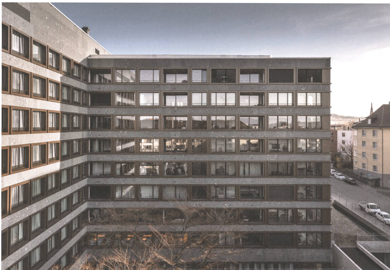
Die «Schönburg» in Bern war einst Sitz der Generaldirektion der schweizerischen PTT-Betriebe. Die neue Fassade mit Naturstein aus dem Wallis und braun eloxiertem Aluminium hat den Ausdruck des Gebäudes verändert, doch in den Grundzügen seinen Charakter bewahrt. Die Loggien sind erst auf den zweiten Blick zu erkennen.
