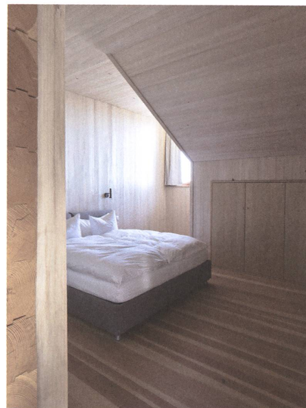
Weisstanne verkleidet die Strickwände der Gästezimmer.
