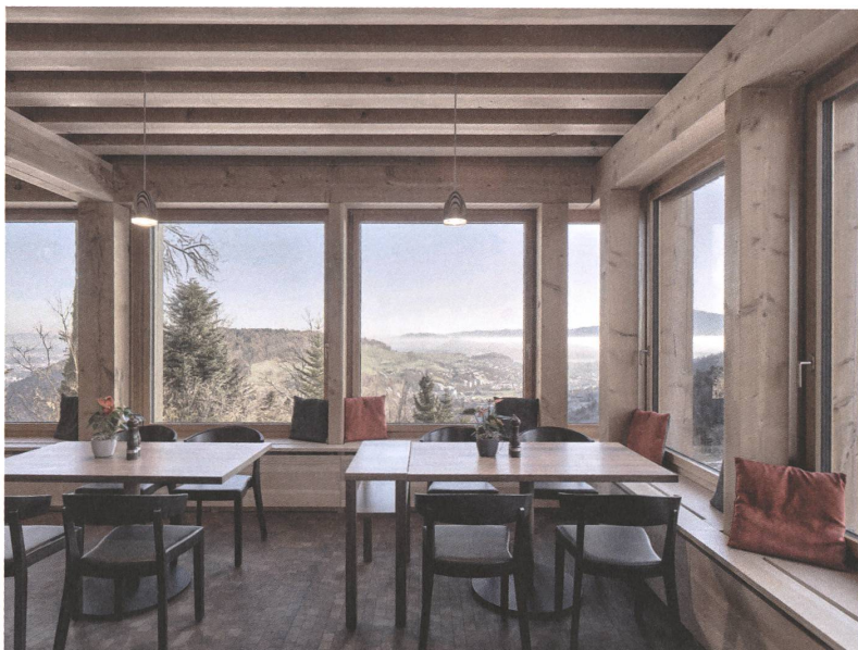
Die Innenständer und Balken des Restaurants tragen eine konventionelle Balkendecke.
