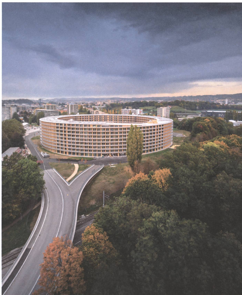
Das Studienwohnheim Vortex spannt am Stadtrand von Lausanne einen neuen Massstab auf.
