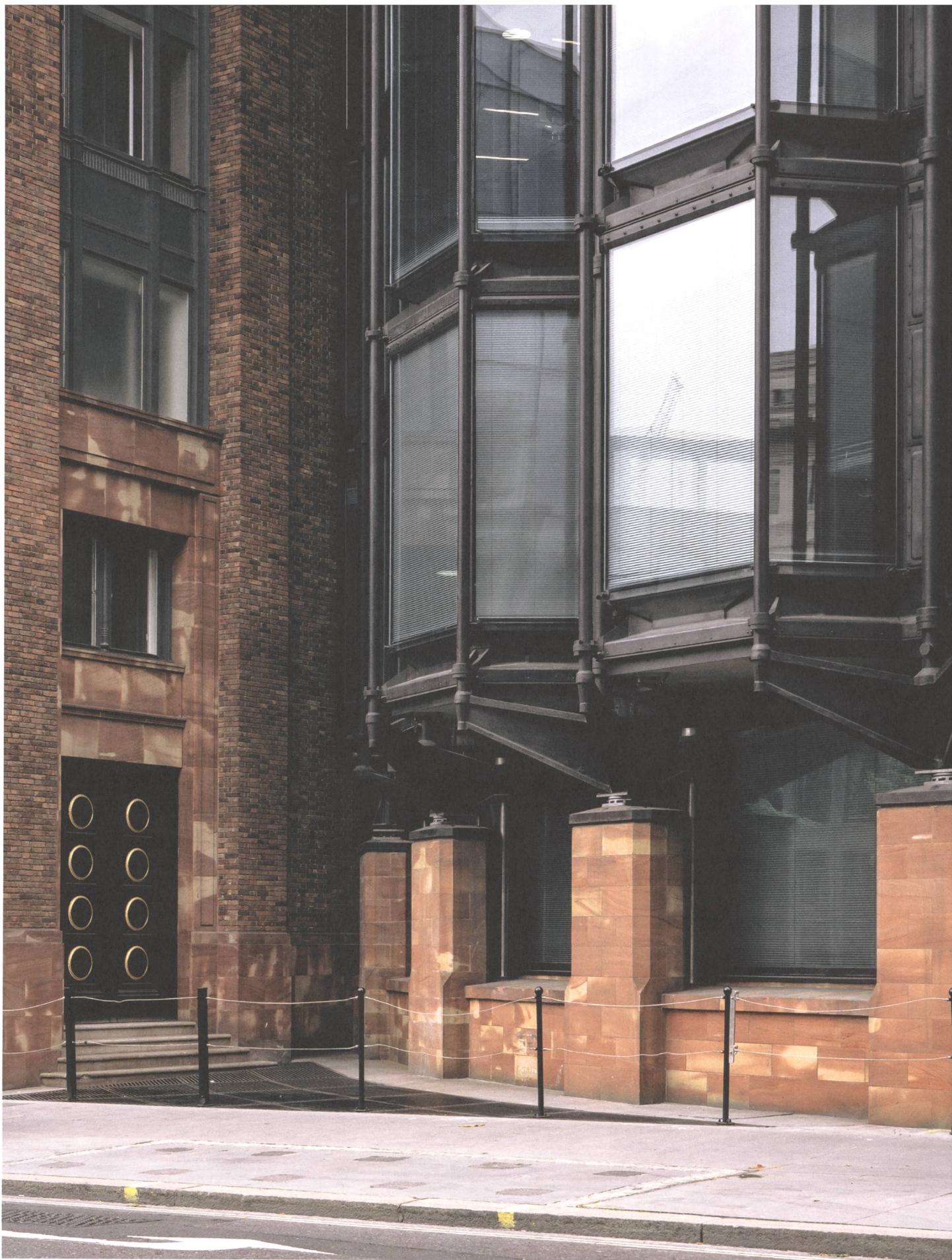
Das Bracken House (1987–1992) der Financial Times : Der neue Teil aus Sandsteinsockel, Bronze und Glas ergänzt zwei alte Flügel aus den 1950er-Jahren.
