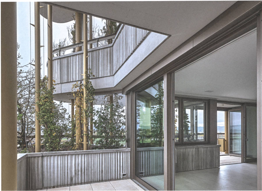
Betonbrüstungen verwischen innen und aussen. Stützen und Rohre tragen, bewässern und dienen als Kletterhilfen.
