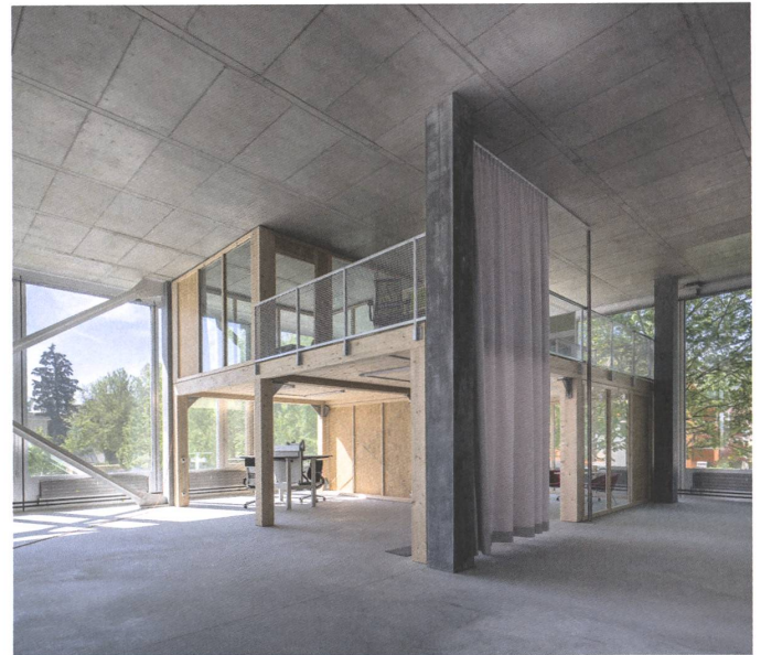
2 Büro- und Gewerbehause Yond in Zürich. | Immeuble commercial et de bureaux Yond à Zurich.
