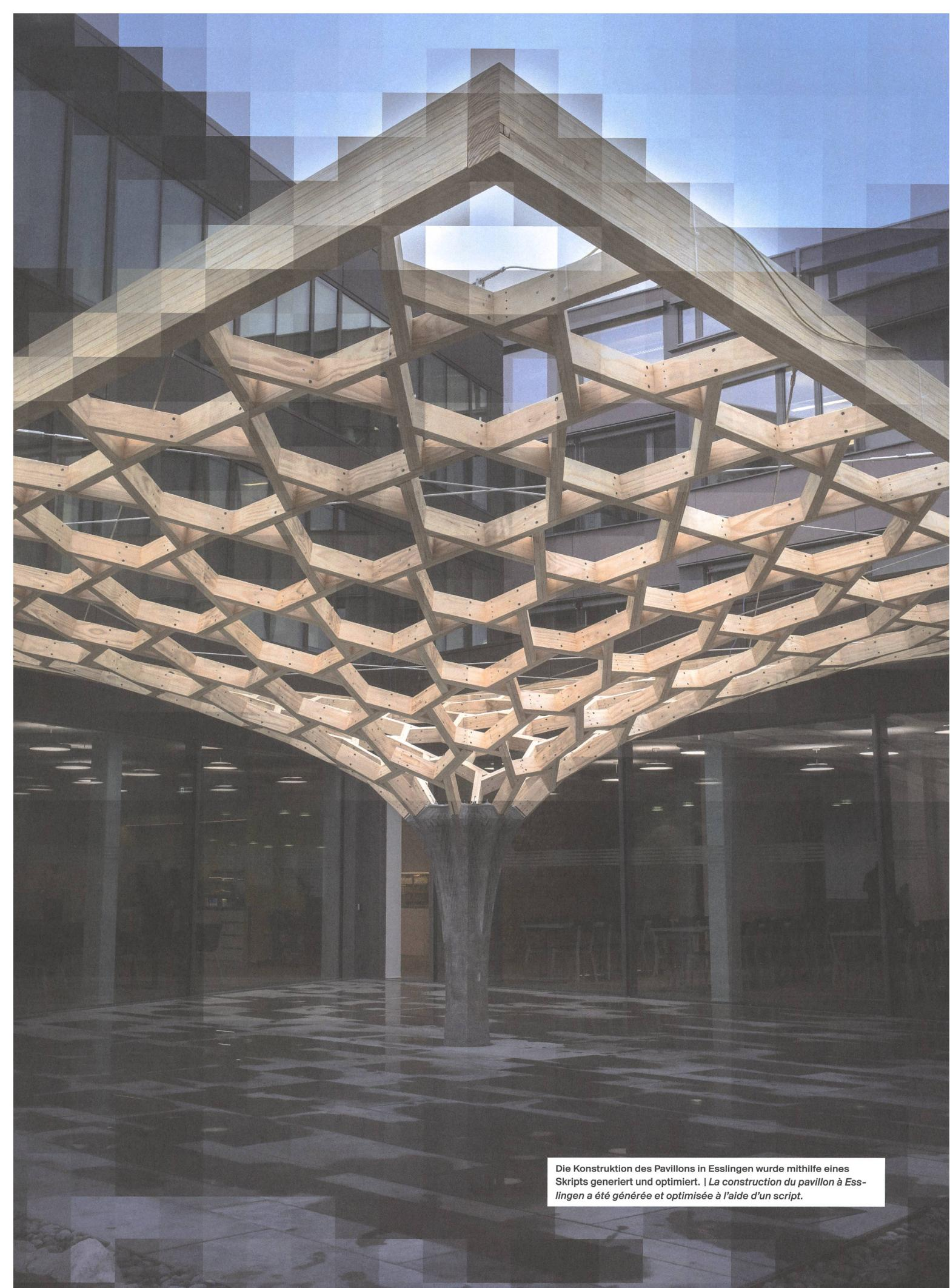
Die Konstruktion des Pavillons in Esslingen wurde mithilfe eines Skripts generiert und optimiert. | La construction du pavillon à Esslingen a été générée et optimisée à l'aide d'un script.
