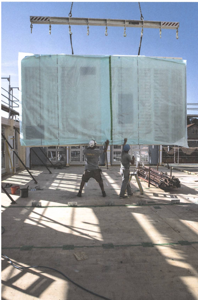
Die Holzkonstruktion wird als Element auf die Baustelle geliefert. | La construction en bois est livrée sur le chantier en tant qu'élément.
