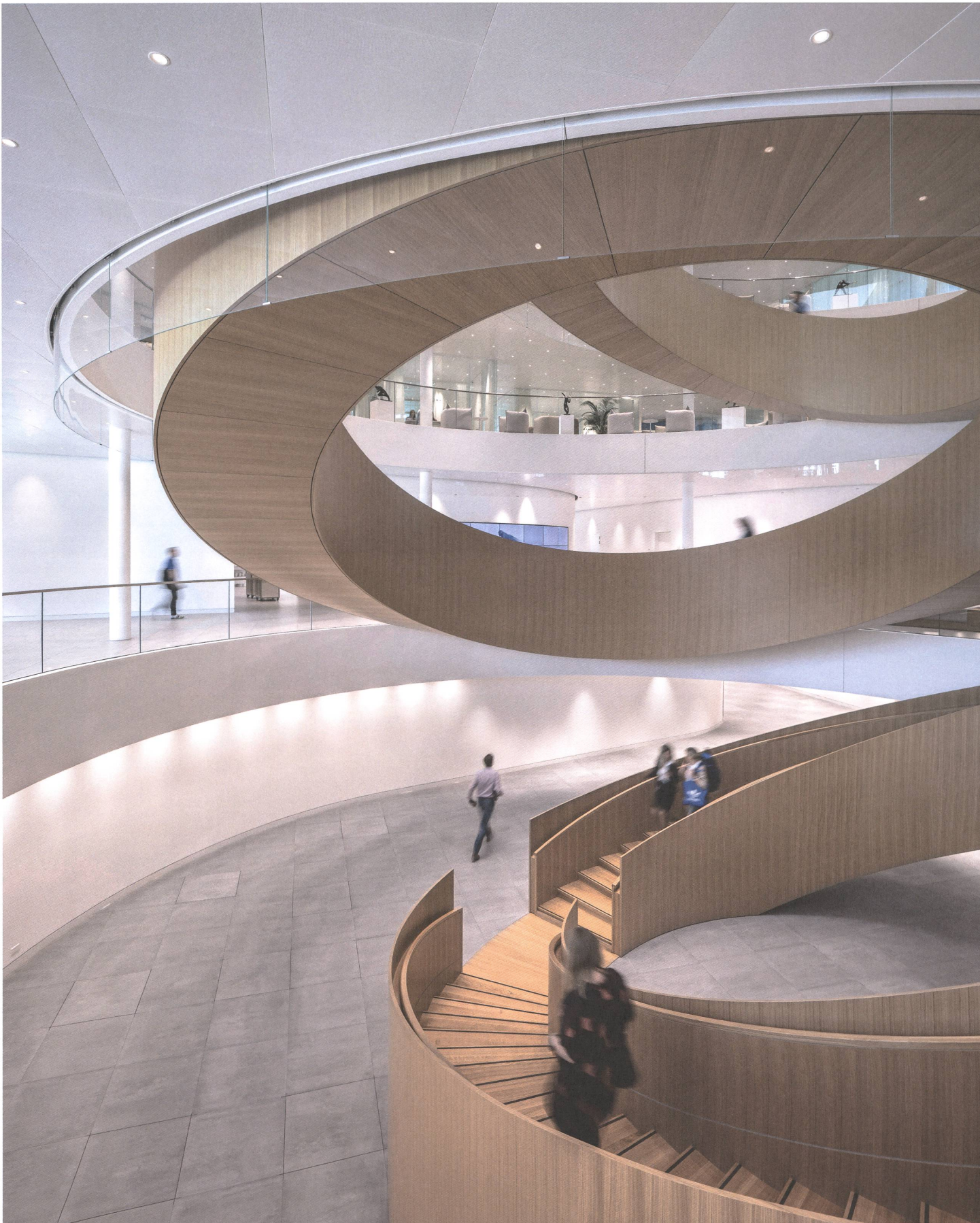
Aufwendige Statik: Im Atrium des IOC-Hauptgebäudes in Lausanne stabilisieren Stahlringe die Geschossplatten, die auf jedem Stockwerk leicht verschoben auskragen.
