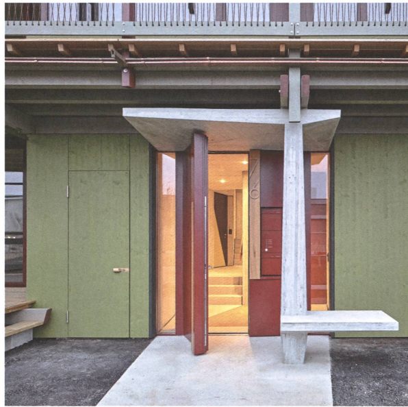
Die Treppenhäuser wachsen als «Betonbäume» aus dem Holzbau heraus.
