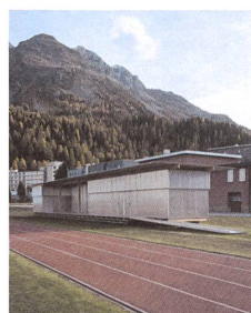
Sportpavillon, St. Moritz GR Walter Bieler und Krähenbühl Architekten Studio
