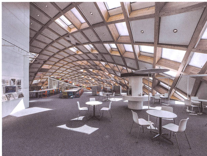
Das Netztragwerk des Dachs besteht aus 4600 unterschiedlichen Hauptelementen.
