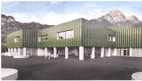
Eine neue Keramikfassade wickelt sich um die Obergeschosse.
