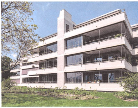
Neubau am einstigen Sitz der «Zürichsee-Zeitung» in Stäfa: Kamintürme prägen die markante Silhouette zum See.
