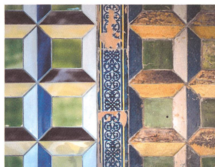
Im Lichthof: links die neuen Fliesen im alten Handwerk hergestellt, rechts der Originalboden.
