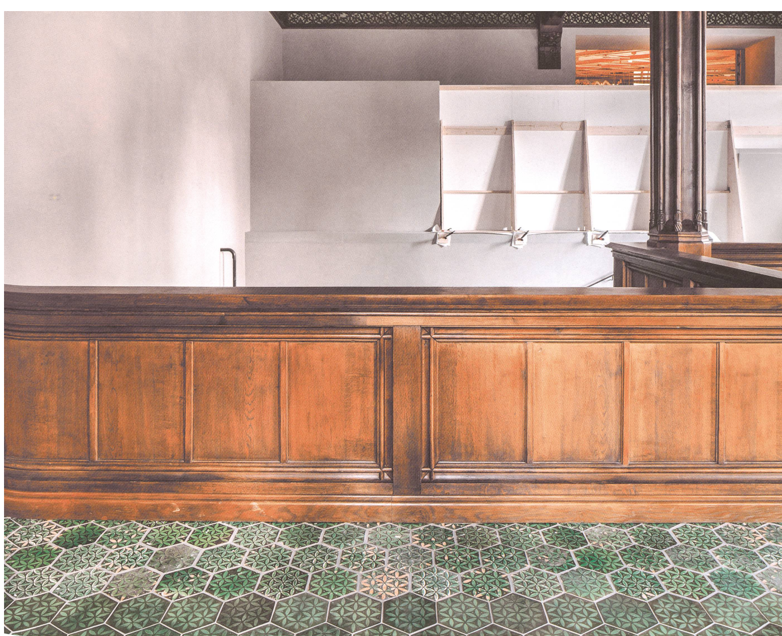
Patronierte Fliesen im Korridor mit der Decke aus dem Schloss Arbon: vorne rekonstruiert, hinten original.
