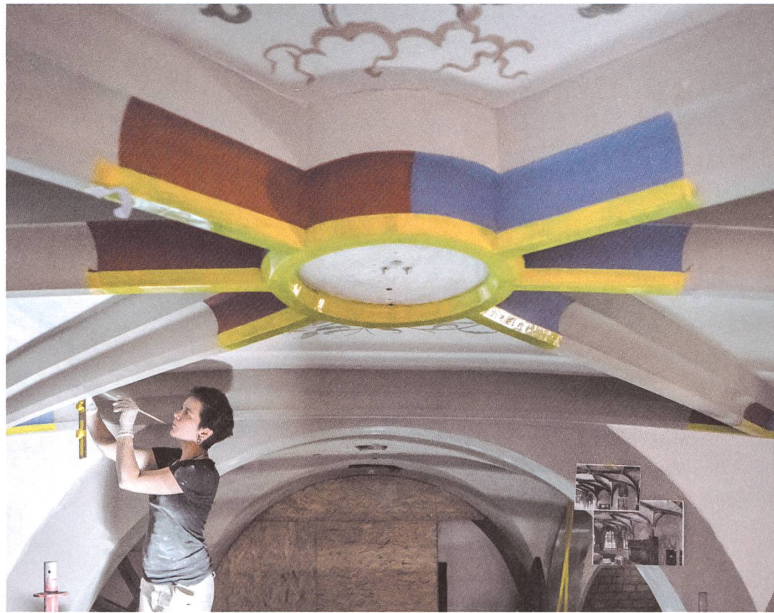
Die Originalbemalung in der Unteren Kapelle war nur auf einer einzigen Farbaufnahme von 1905 erhalten, auf die sich die Rekonstruktion teilweise abstützen konnte.
