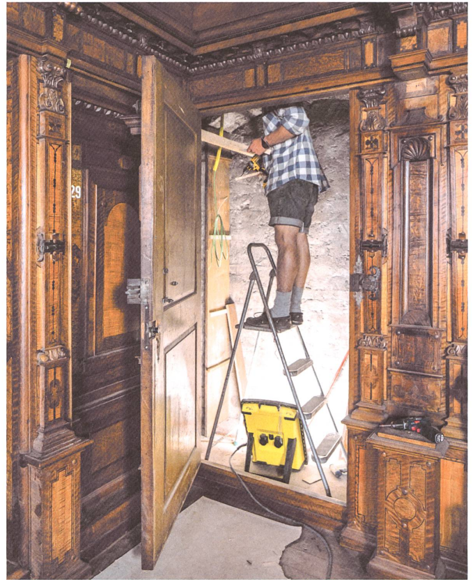
Auch die Stromkabel für die Beleuchtung werden, wie hier im Seidenhof-Zimmer, hinter den historischen Ausstattungen untergebracht.
