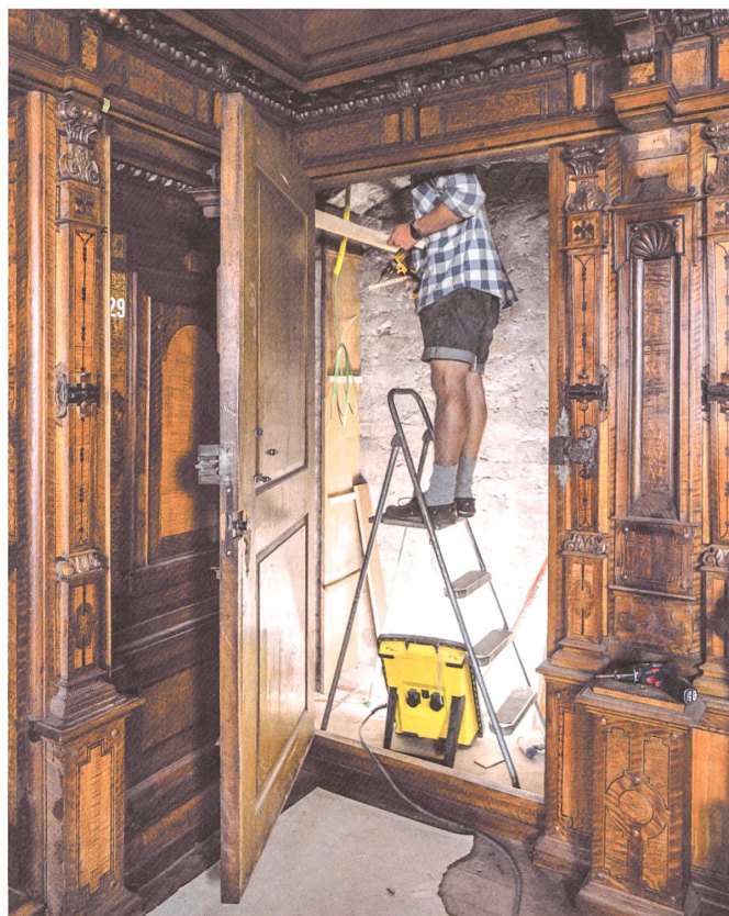
Auch die Stromkabel für die Beleuchtung werden, wie hier im Seidenhof-Zimmer, hinter den historischen Ausstattungen untergebracht.
