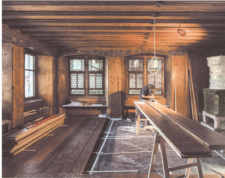
Stück für Stück wurden die Historischen Zimmer ausgebaut. Für die Äbtissinnen-Zimmer des Fraumünsterklosters waren die Berliner Lars Geissler und Knut Lewandrowski zuständig.
