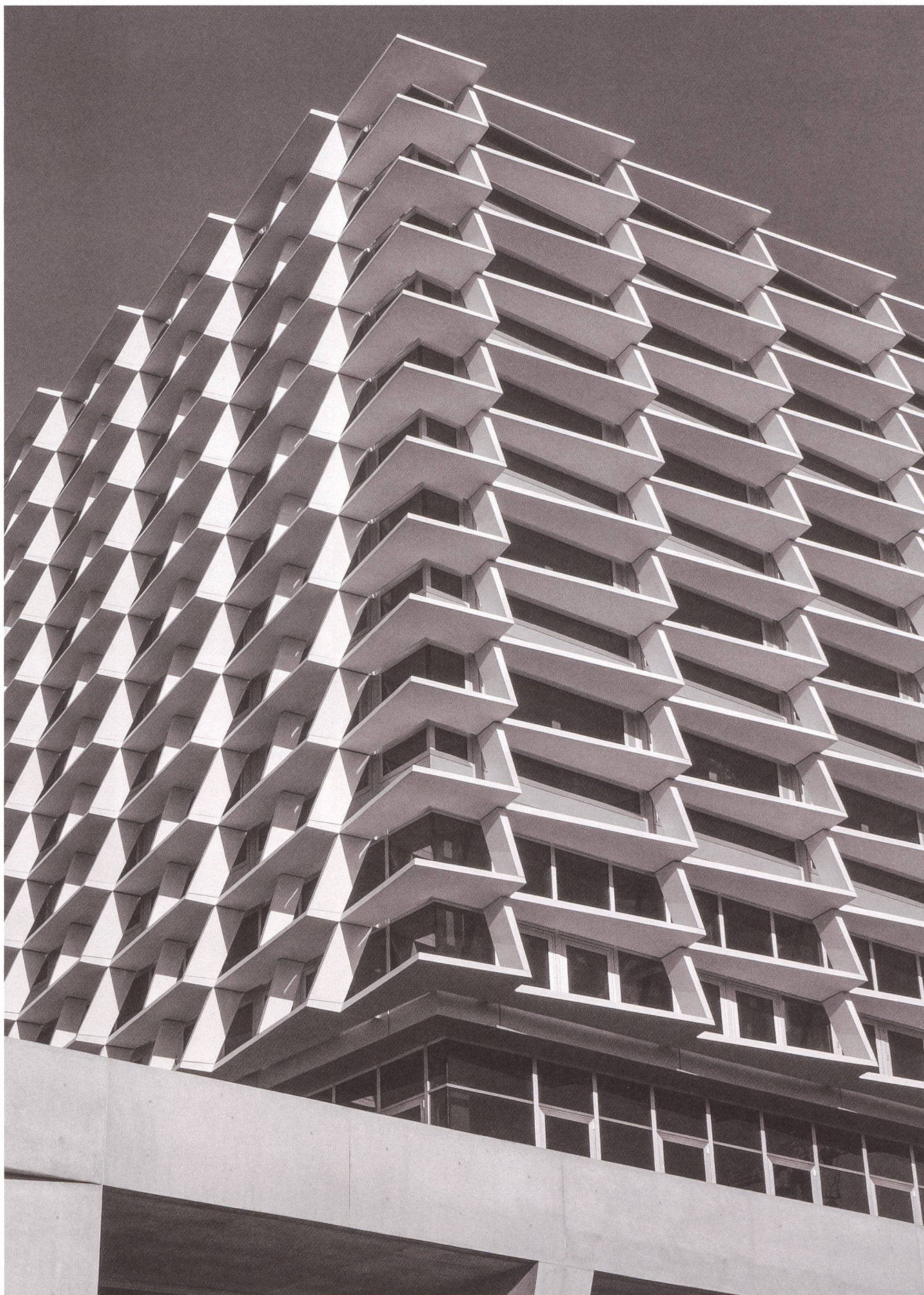
5 Brise-Soleils verwandeln das Bürgerspital Solothurn in eine gigantische Skulptur. Foto: Reto Gmür
