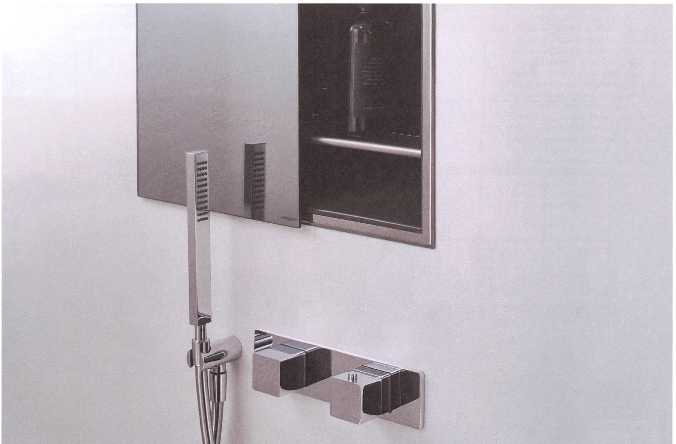
Die in die Wand integrierte Nischenablage ergänzt die bodenebene Dusche: Sie spart Platz und verhindert Wasserränder und Schmutz.
