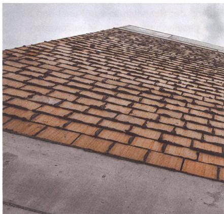
Besonders auffällig ist der herausgequetschte Mörtel.
