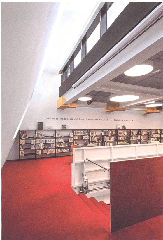
Die nötige Brandschutzdämmung ist orange gestrichen, als «Ornament der Austerität».
