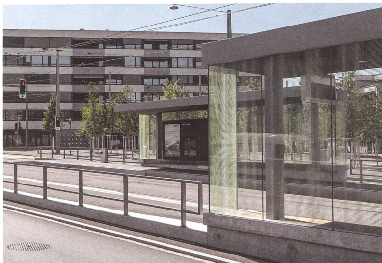
Mit einfachen Formen und einer vorhangartigen Rückwand prägen die Haltestellen die Stadtlandschaft entlang der Limmattalbahn.
