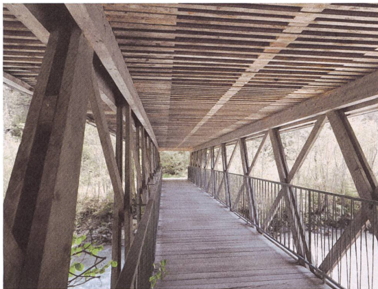
Bemerkenswert: doppelte Druck-, einfache Zugstreben.
