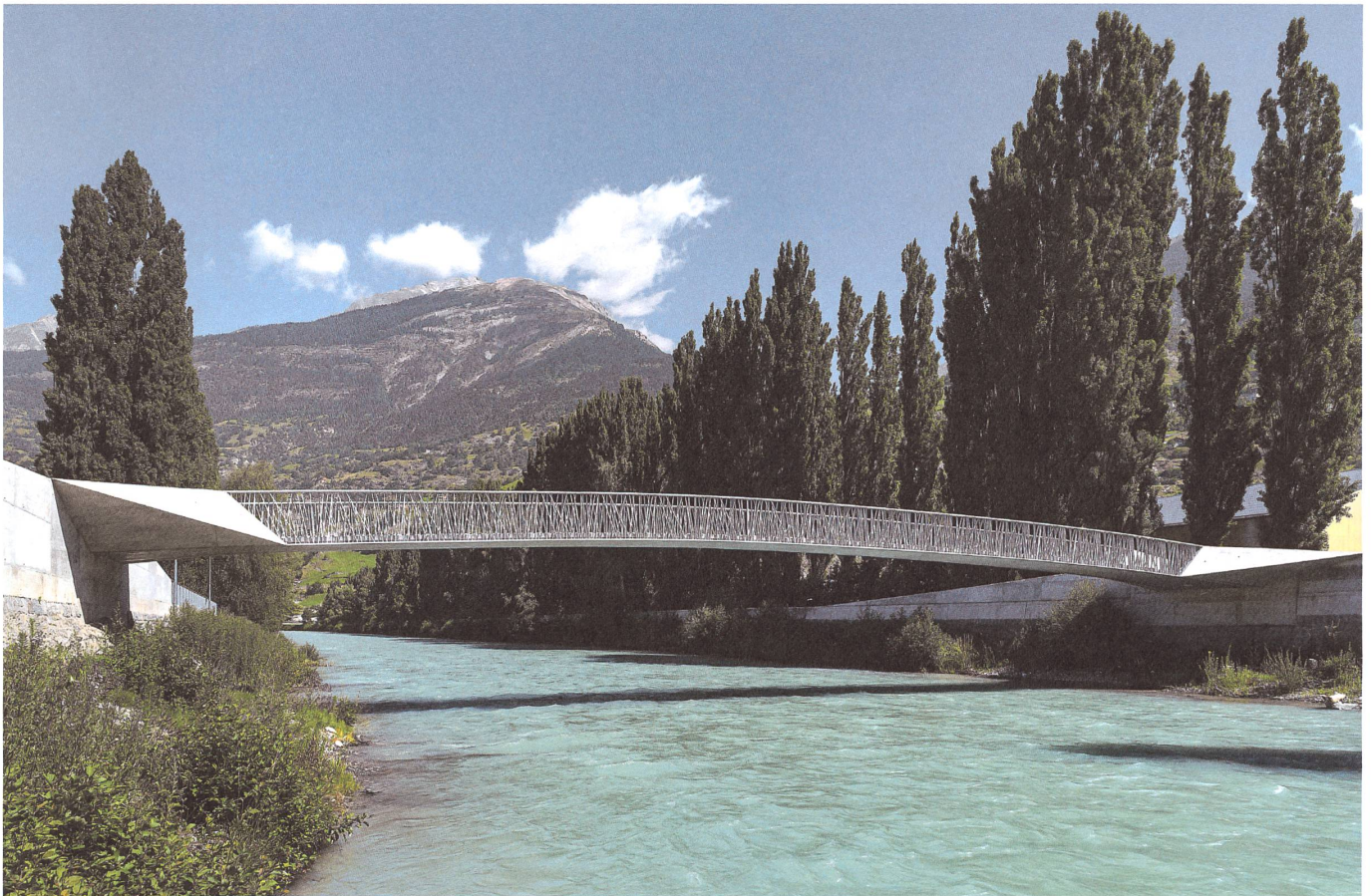
Vispa-Brücke bei Visp: Die Brücke als geschwungene Linie in einer von Geraden dominierten künstlichen Flusslandschaft. Foto: Thomas Jantscher
