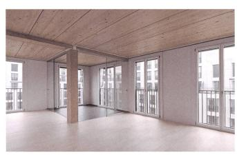
Sichtbare Stützen und Balken zeigen, wie der Holzbau trägt.
