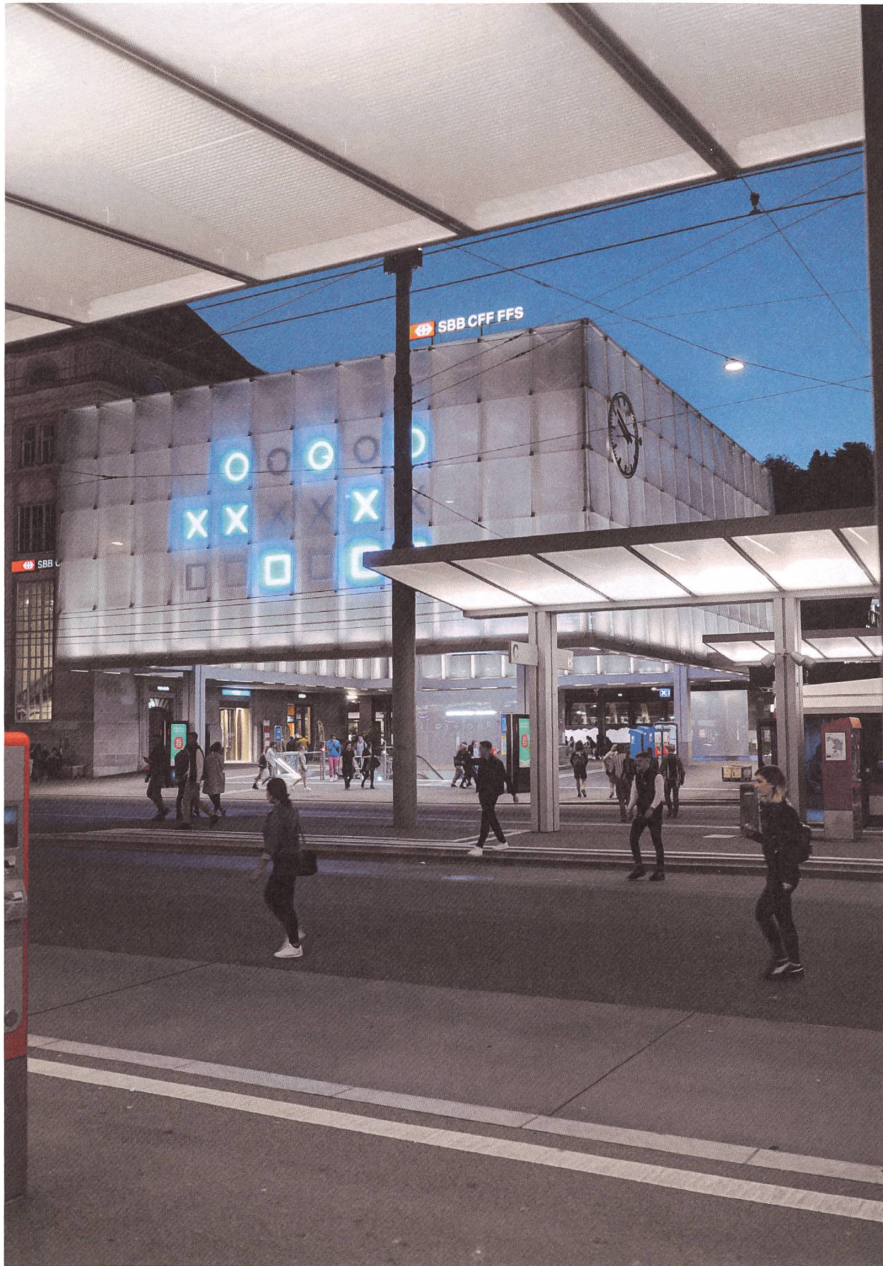
Der gläserne Kubus verbindet Platz und Bahnhof. Er ist der neue Mittel- und Schwerpunkt der Verkehrsdrehscheibe.
