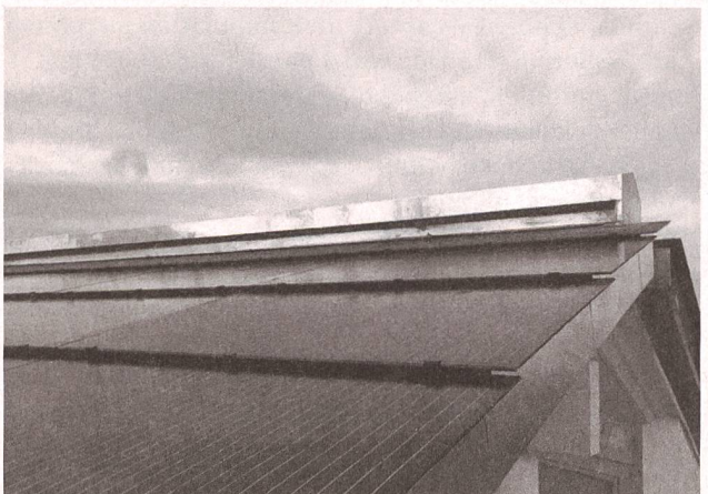
Dünn trotz neuer Dämmung und Hybridkollektoren (PV und Wärme): Umbau Kirche Ebmatingen von Daniel Studer.
