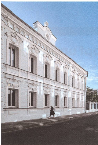
Schweizer Botschaft in Moskau: Die restaurierte Fassade des Altbaus.
