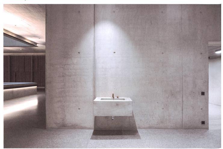
B wie Beton: Die Rippendecken, die Stützen, die Hoffassaden und sogar die Waschbecken sind betoniert.
