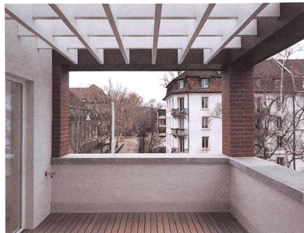
Ziegelstützen? Darin verstecken sich Holzstützen.
