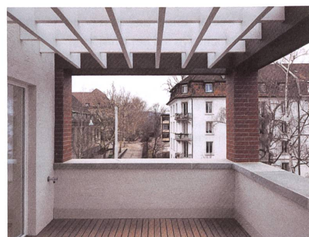
Ziegelstützen? Darin verstecken sich Holzstützen.
