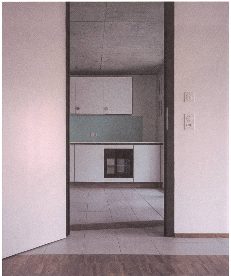
Im Grossen frei von Berührungängsten: Stahlzargentüren, Feinsteinzeugplatten, Riemchenparkett, Kunstharzküche.
