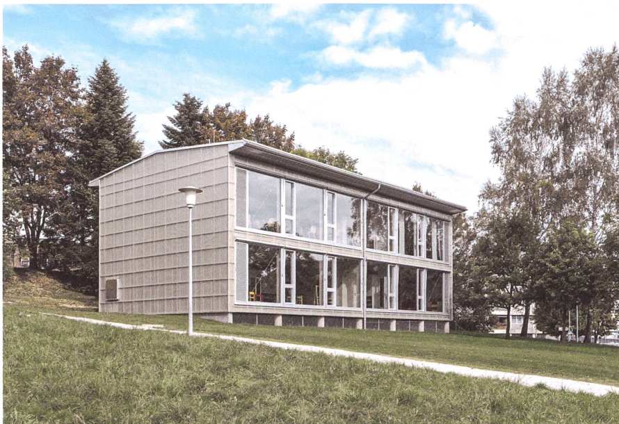
Die Schulpavillons in Freiburg passen sich ein-, zwei- oder dreigeschossig dem Bedarf und der Umgebung an.
