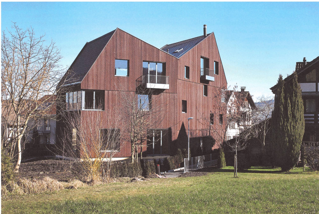
Das geknickte Haus in Oberrieden hat ein Fassadenbild, das auf eine Bretterlänge von sechs bis sieben Metern abgestimmt ist.
