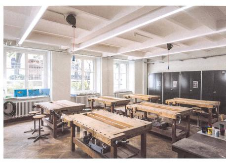
In den Werkräumen bleibt der Lärm erträglich, denn das freigelegte, um Rippen ergänzte Tonnengewölbe bildet eine robuste Akustik.
