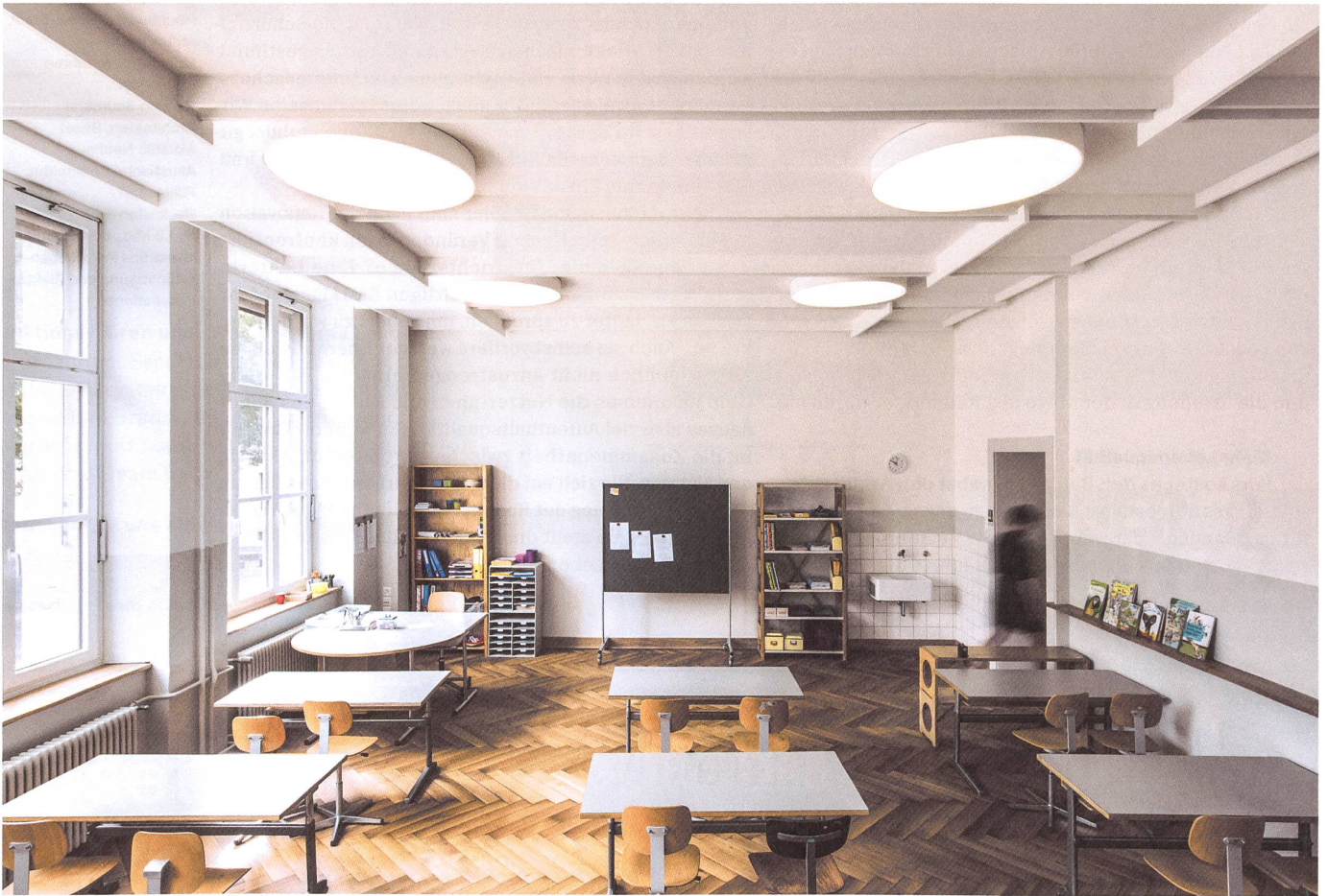
Sprechen und Zuhören erleichtert: Die Rippen an Wand und Decke sowie die Ablage aus Eichenholz an der Längswand sind nicht nur raum-, sondern auch klangbildend.
