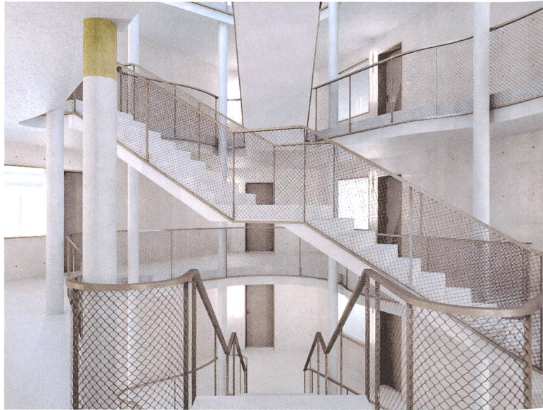
Der Patio ist auch Treppenhaus.
