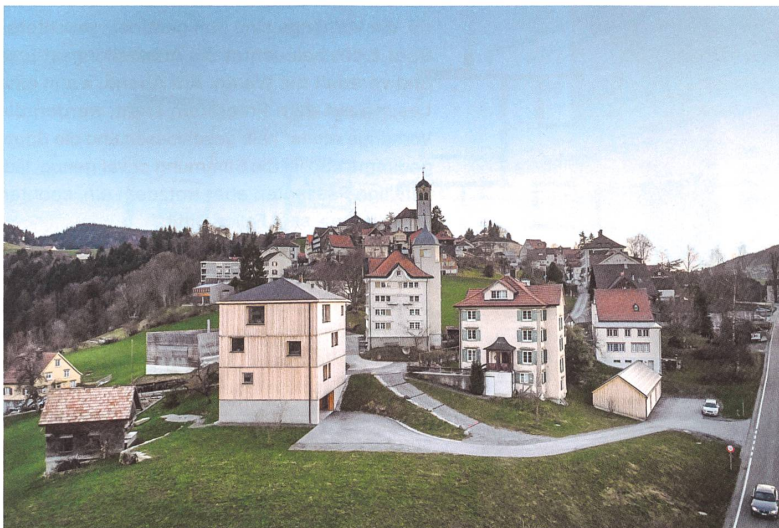
Ein Fremdling, der sich einpasst: Zweifamilienhaus in Trogen.
