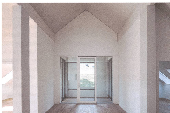
Weiss lasierte Betonstützen kontrastieren den glatten Leichtbau.
