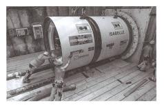
Der Bohrkopf fürs Microtunneling wird positioniert. ILa tête de forage pour le microtunnelage est positionnée.
