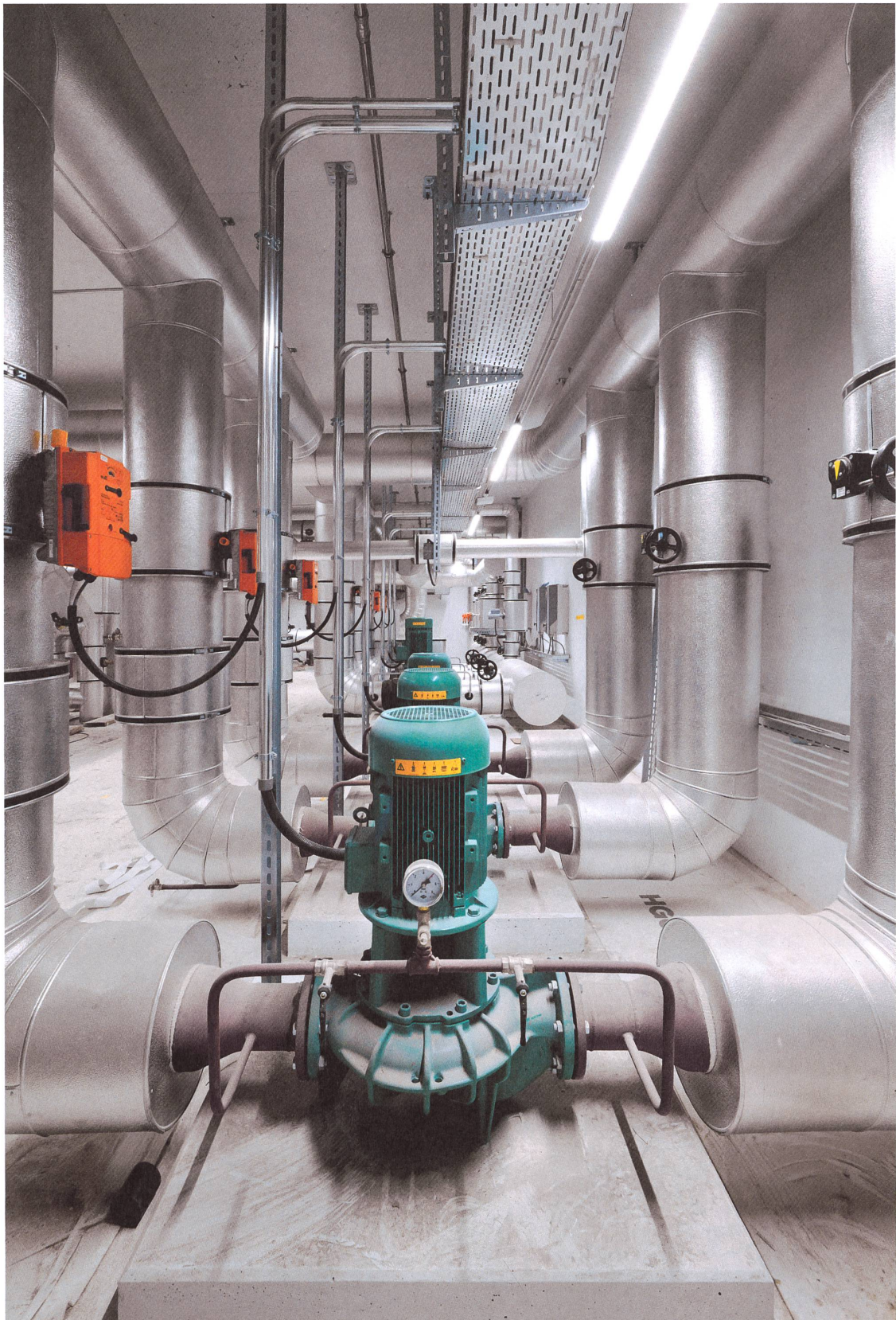
Die Energiezentrale Pont-Rouge in Genf verteilt Energie aus 300 Erdsonden. | La centrale énergétique Pont-Rouge de Genève distribue l'énergie qui provient de 300 sondes géothermiques.
