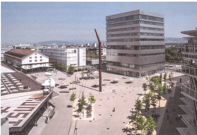
Wie eine Google-Nadel besetzt der monumentale Lichtmast die Mitte des Freilager-Platzes in Münchenstein. Die 8000 Quadratmeter grosse Fläche macht vielfältige Nutzungsangebote.
