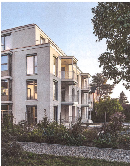
Blick von Süden auf das Haus an der Bachtobelstrasse.
