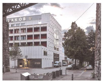
Vom Beton über farbige Keramik bis zur gestrichenen Aussendämmung: Das Gewerbehaus im Zürcher Kreis 5 vereint die unterschiedlichen Welten von Industriebau und Palazzo.
